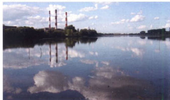
Любовское водохранилище (вид на Новомосковскую ГРЭС)
