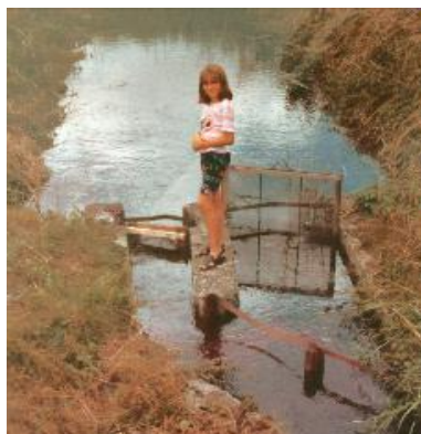
Рисунок 12 – Сбросное сооружение с ловушкой для учета молоди
