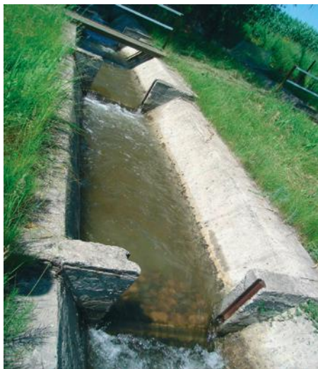
Рисунок 8 – Перекаты в нерестовых канавках, создающие скорость течения, необходимую для привлечения производителей на нерест
