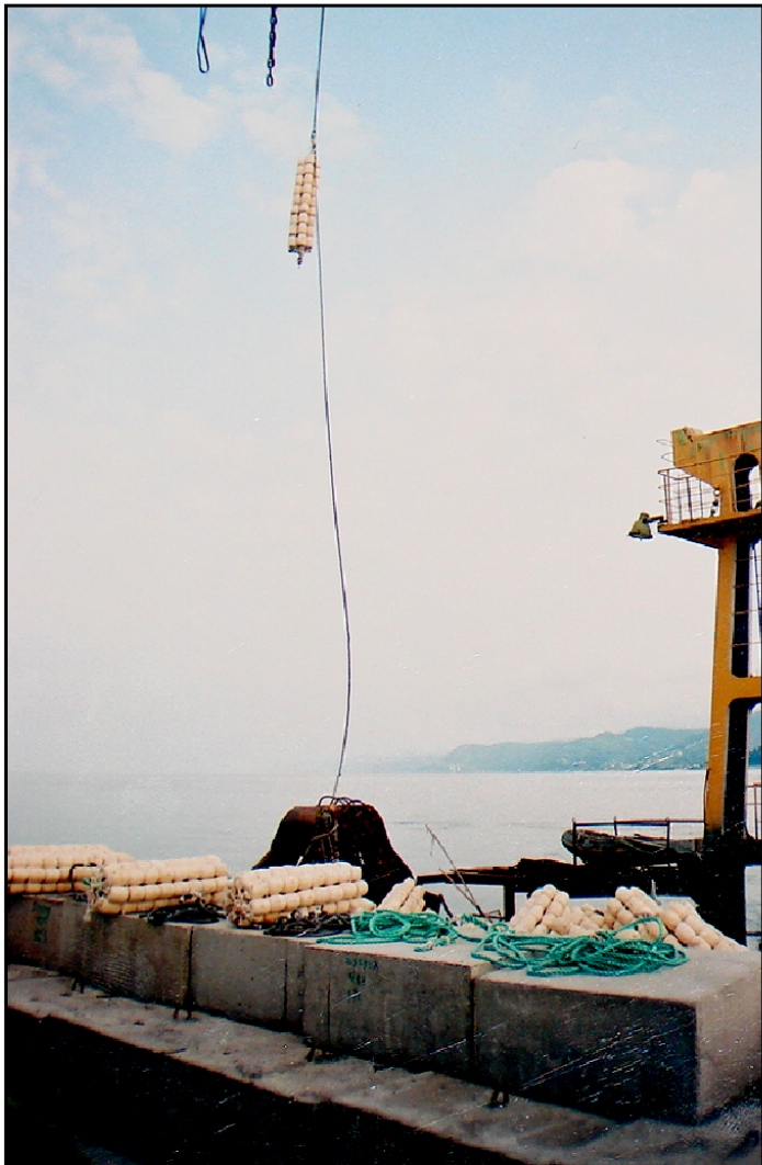
Рисунок 4 – Постановка грузов с основными буйми с плавкрана в воду
