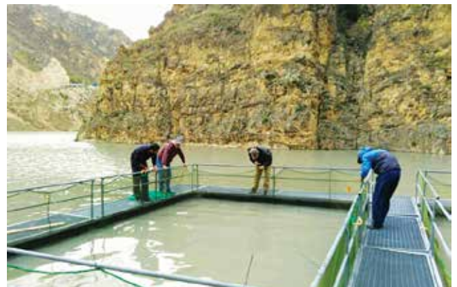
Рисунок 3. Монтаж садковой линии на Гоцатлинском водохранилище
