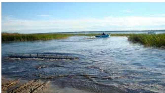
**Рисунок 2.** Начало процесса рыхления донных отложений озера заморного типа
