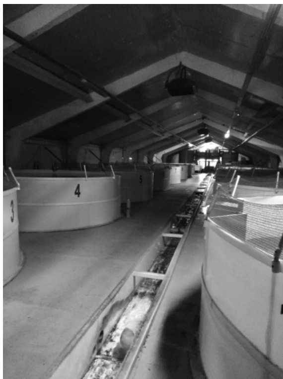
Рис. 1. Установка замкнутого цикла по выращиванию осетровых в рыбхозе «Ушня» (фото Р.К. Ахтямовой)
