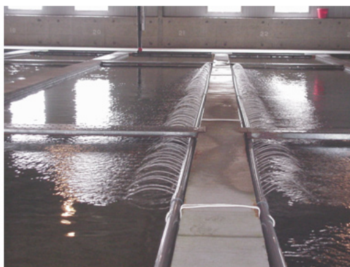
Рис. 6 – Аэрация питомных каналов в период кормления молоди, Охотский ЛРЗ
