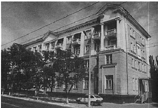
Рисунок 1. Здание ЦНИОРХ в г. Астрахань
