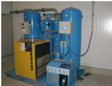
Иллюстрация 5.2 Генератор кислорода. Необходим контроль и уход за специальным оборудованием.
