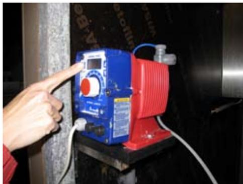
Иллюстрация 2.16 Насос-дозатор для регулирования pH путем добавления заранее заданных количеств NaOH. Для полной автоматизации регулирования уровня pH насос может быть подключен к датчику pH.
