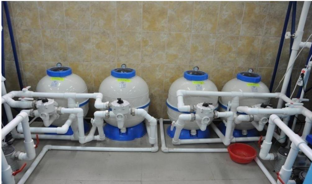
Рисунок 10. – Механические фильтры
