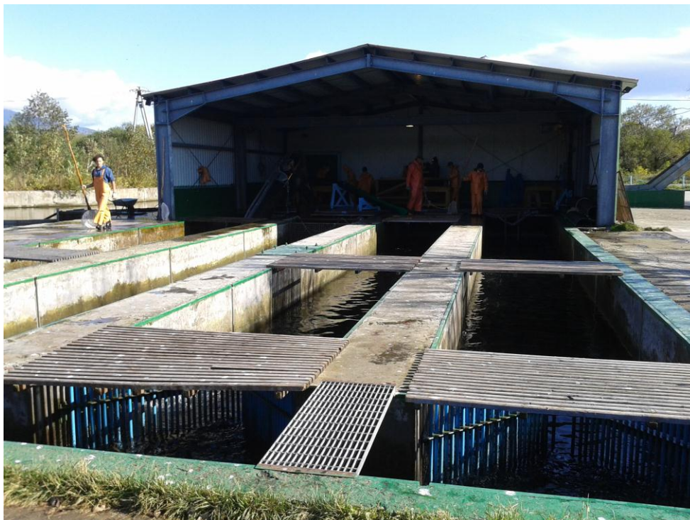
Рисунок 5 – Бетонные садки на забойке Курильского ЛРЗ
