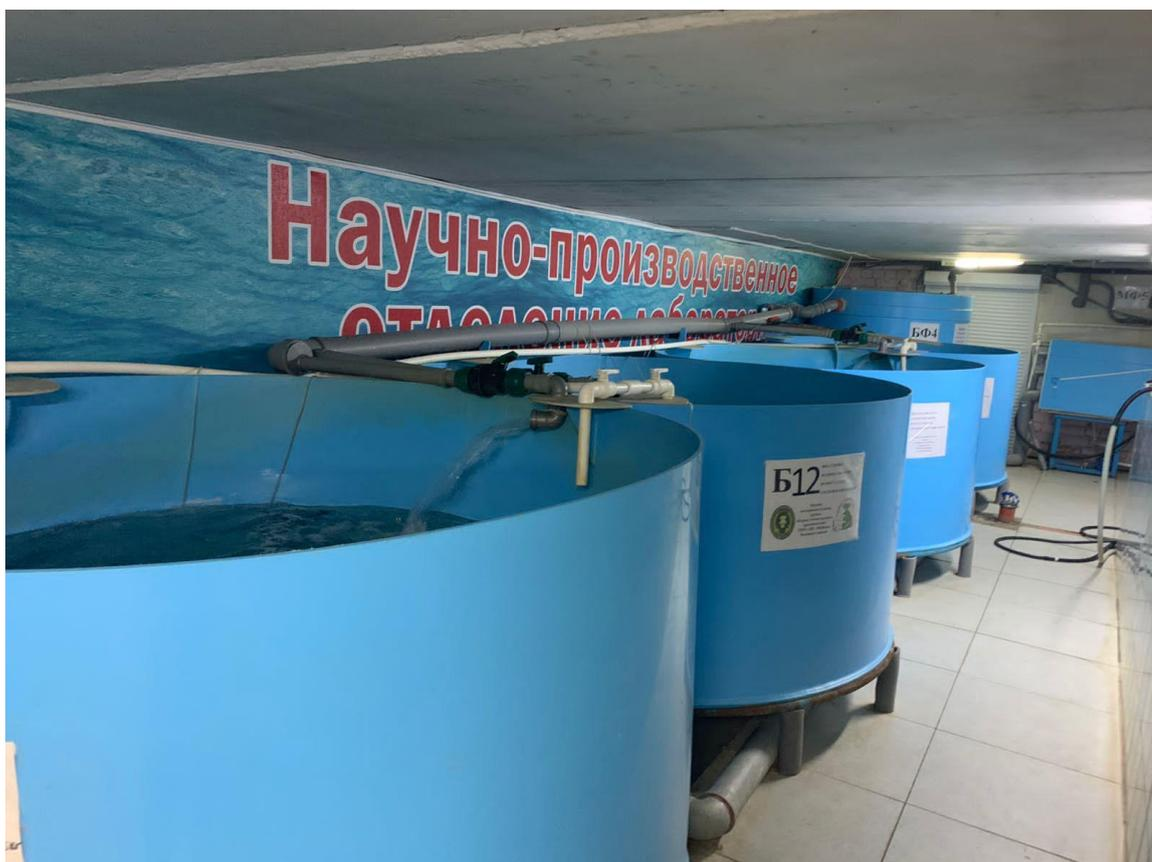
Рисунок 1 – Установки замкнутого водообеспечения для содержания осетровых рыб в условиях ПНИЛ «Разведение ценных пород осетровых» ФГБОУ ВО Волгоградского ГАУ
