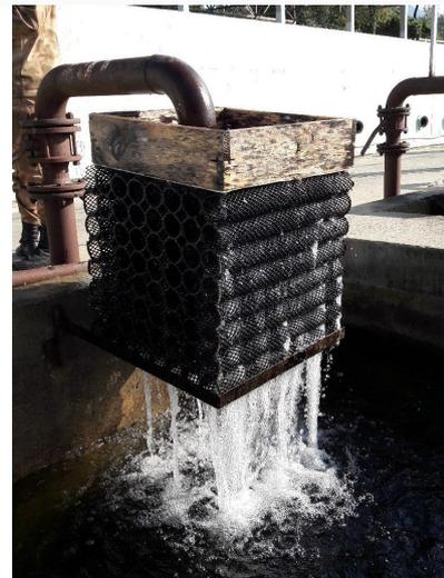
Рисунок 6.31 – «Соты» неподвижной загрузки и биофильтр с неподвижной загрузкой
