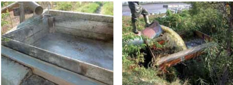
Деревянная структура с основанием в виде фильтра, помещенным под водопроводной трубой, предотвратит попадание нежелательной рыбы в пруд. Фильтр для мелкого (слева) и для большого пруда (справа).
