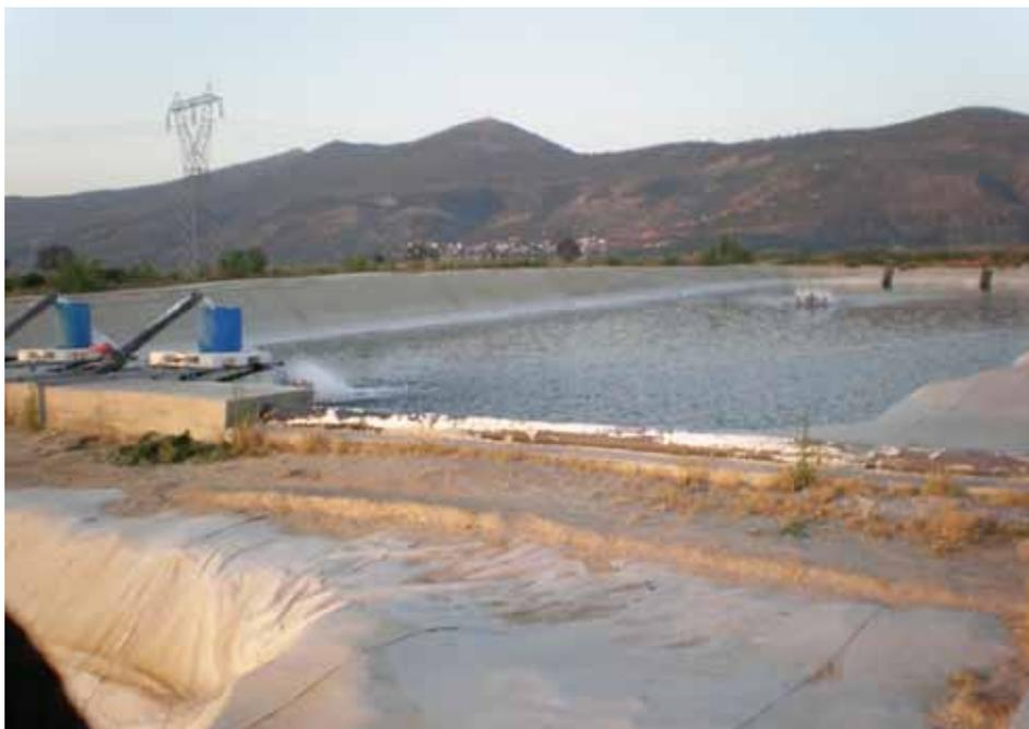
**Рисунок 28:** Земляные пруды с покрытием ложа геомембраной.
