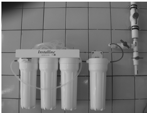
Рис. 98. Установка для фильтрации морской воды.
