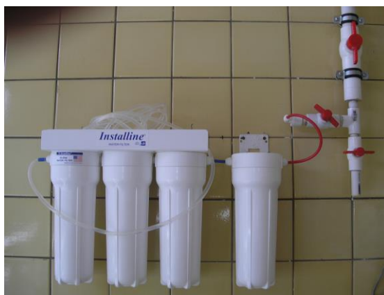
Рис. 113. Установка для фильтрации морской воды в питомнике ИМБИ.
