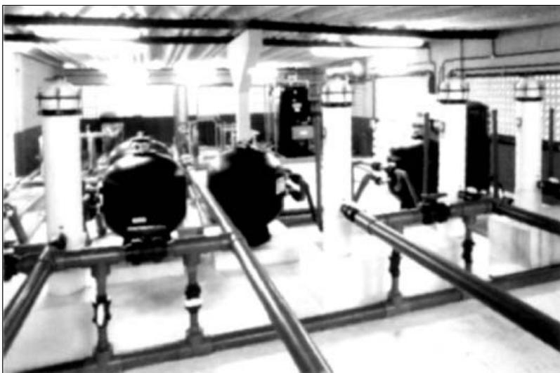
*Рис. 20. Система трехступенчатой очистки поступающей морской воды*
