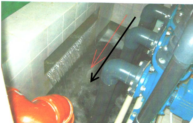
Рис. 12. Лампы облучателя должны всегда находиться в воде!
