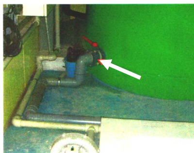
Рис. 55. Затвор для слива загрязнений в канализацию
