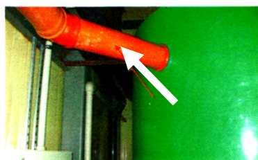
Рис. 54. Слив очищенной воды из фильтра
