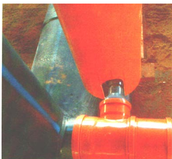
Рис. 39. Кран полного слива воды из бассейна в процессе выполнения монтажных работ
