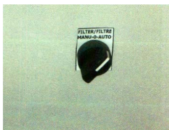
Рис. 33. Нормальное положение выключателя фильтра
