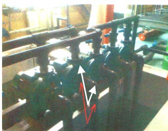
Рис. 15. Всасывающий патрубок с фланцем
