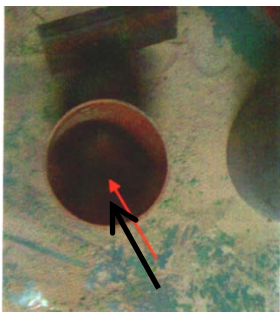
Рис. 37. Кран полного слива воды из бассейна
