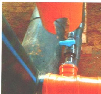
Рис. 39. Кран полного слива воды из бассейна в процессе выполнения монтажных работ
