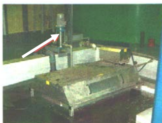
Рис. 61. Насос промывки фильтра
