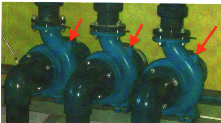
Рис. 45. Пробки на «улитках» для заполнения насоса водой
