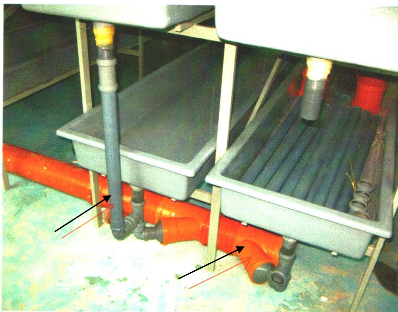
Рис. 11. Трубопровод сбора воды (показан стрелками)
