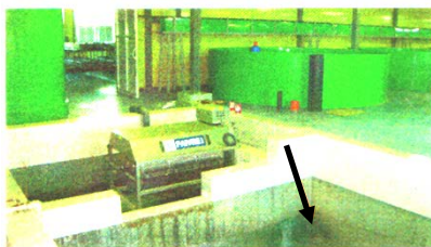
Рис. 51. Бетонное отделение прямка, в котором располагается биологический фильтр
