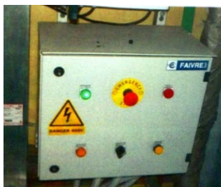
Рис. 62. Шкаф управления фильтром
