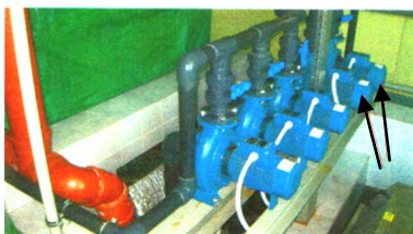
Рис. 13. Насосы подачи воды на конус-оксигенатор
