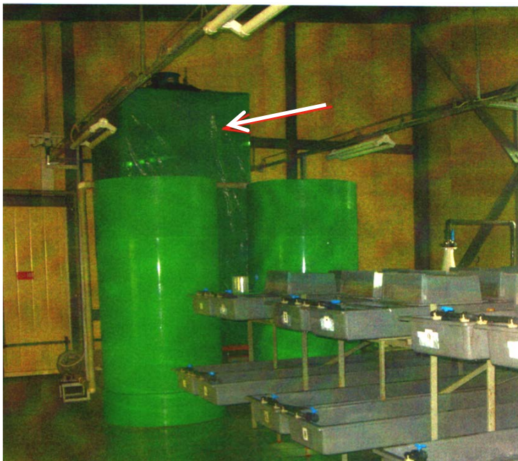
Рис. 26. Капельный фильтр
