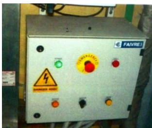
Рис. 32. Шкаф управления фильтром
