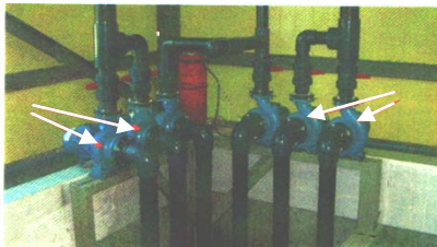
Рис. 41. Насосы подачи воды на лотки раздачи к бассейнам, попарно на каждую сторону
