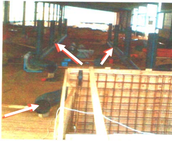
Рис. 40. Трубопроводы сбора воды во время проведения монтажных работ
